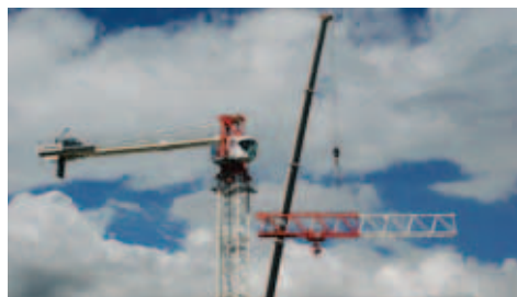
Montaje y desmontaje de grúas torre
